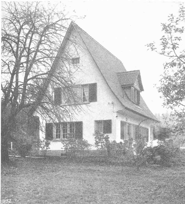
Abb. 10. Haus Arch. F. Ulrich, von Nord-West.
