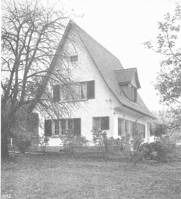
Abb. 10. Haus Arch. F. Ulrich, von Nord-West.
