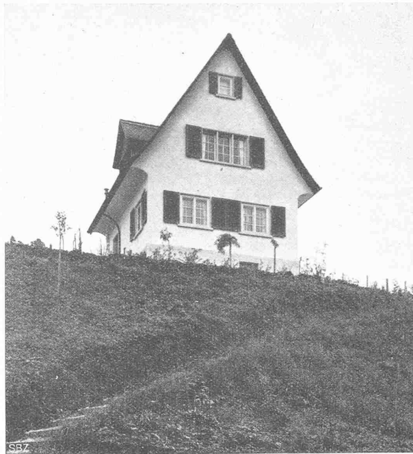
Abb. 1. Haus Dr. Hans Grob in Zürich-Leimbach, von Süd-Ost.
