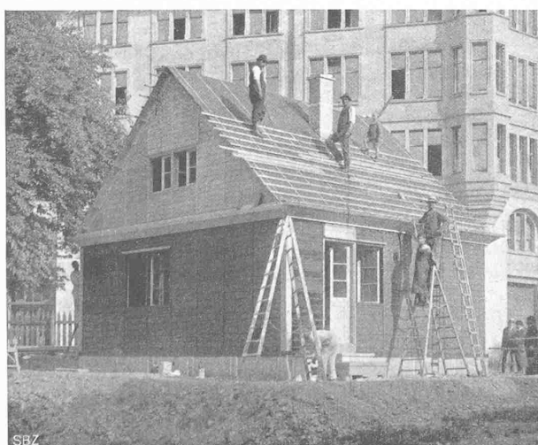
Abb. 21. Baufortschritt am 30. Juli 1919 nachmittags.
