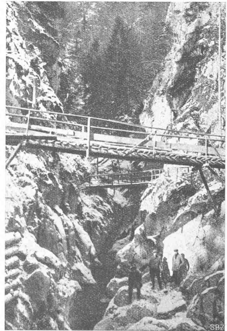
Abb. 6. Blick flussabwärts in den Eingang zur Gorge de Russille, nach Umleitung des Wassers.
