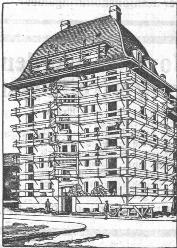
Ansicht eines eingerüsteten Hauses
