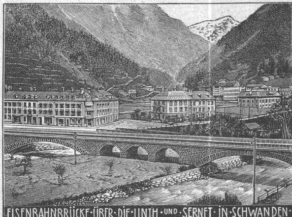
EISENBAHNBÜCKE ÜBER DIE LINTH UND SERNF IN SCHWANDEN
