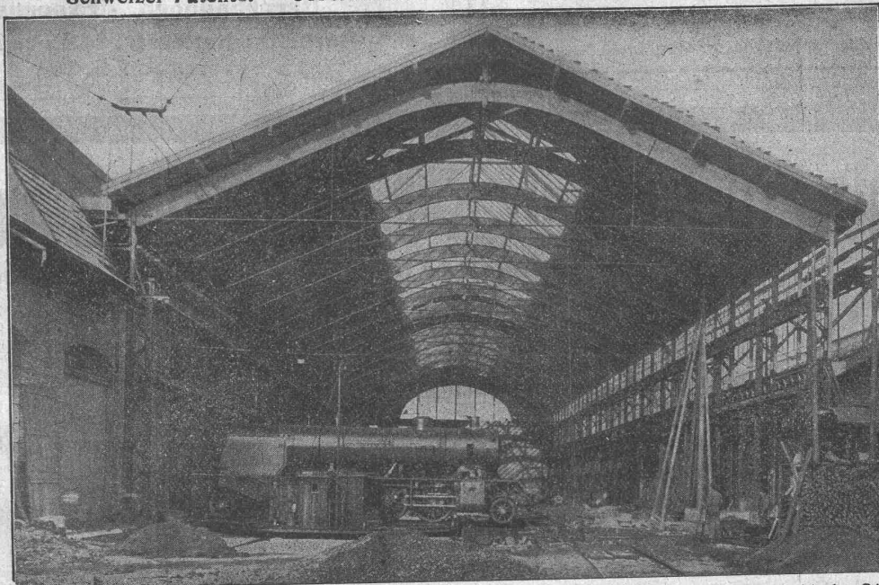
Montagehalle der Schweiz. Lokomotiv- und Maschinenfabrik Winterthur. Spannweite der Hetzerbinder 24½ m.
