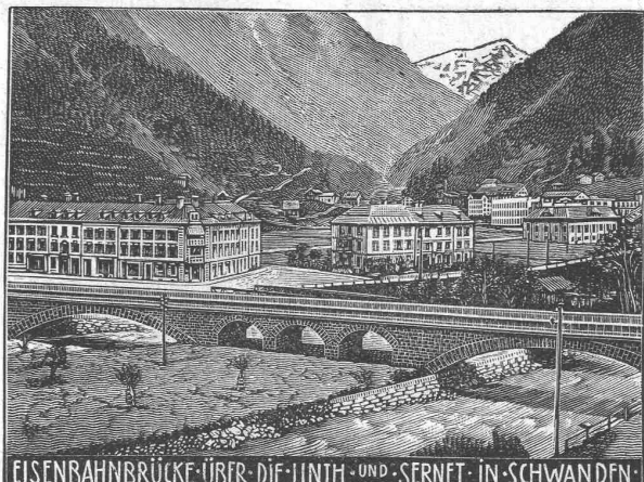
EISENBAHNBRÜCKE ÜBER DIE LINTH-UND-SERNFT IN SCHWANDEN
