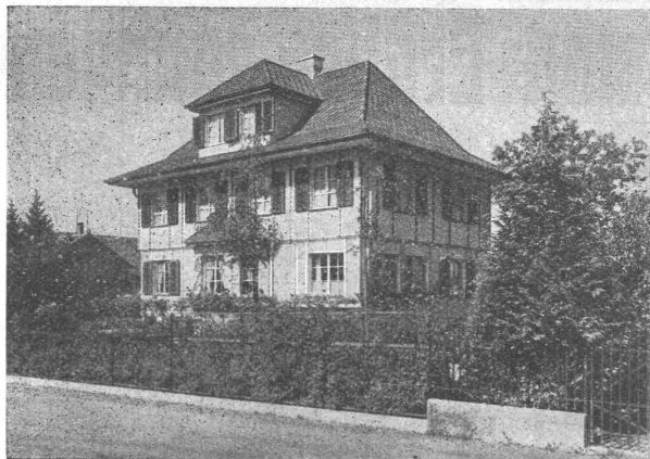
Eternithaus in Winterthur nach System Fritschi & Zangerl, Arch. Bedachung: Eternit, wagrechte Deckung, kupferbraun. Fassade: Grosse Eternitplatten.
