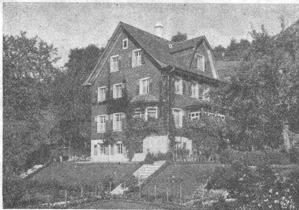
Eternit-Wohnhaus in Zug.
