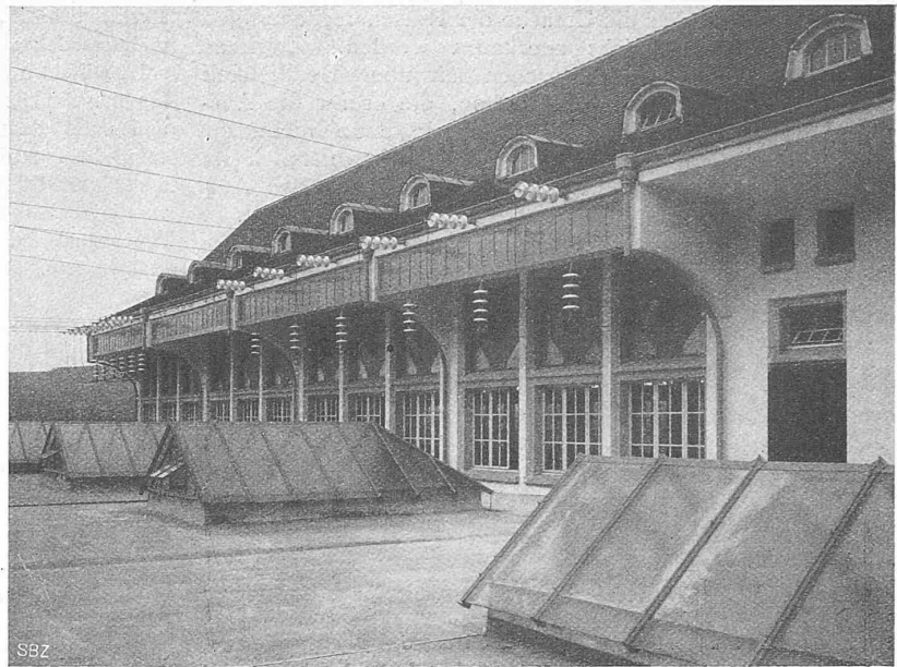
Abb. 138. Ausführung der abgehenden Leitungen für 50000/70000 V des Kraftwerks Gösgen.
