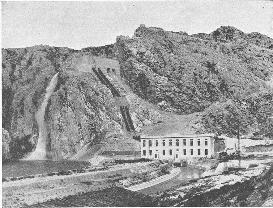
Abb. 24. Gesamtbild von Wasserschloss, Druckleitung, Maschinenhaus und Unterwasser-Kanal.
