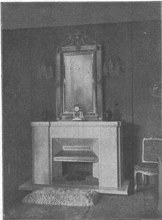
Elektrisches Cheminée als Speicherofen kombiniert mit Holz- oder Kohlenfeuerung.
