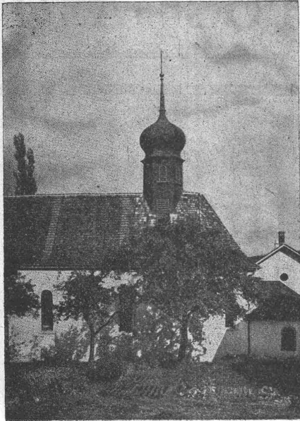
Kapelle in Spreitenbach, Kt. Aargau. Dachreiter in Eternit, geschlaufte Deckung, kupferbraun.
