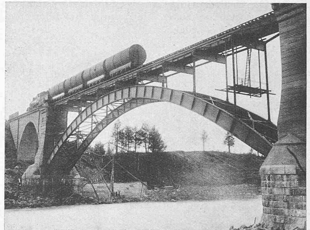
Abb. 16. Vollwand-Zweigelenkbogen von 55,8 m über den Pite-Fluss.
