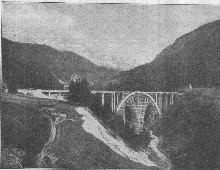
Chur-Arosa-Bahn. Brücke bei Langwies während des Baues, Spannweite 100 m.
