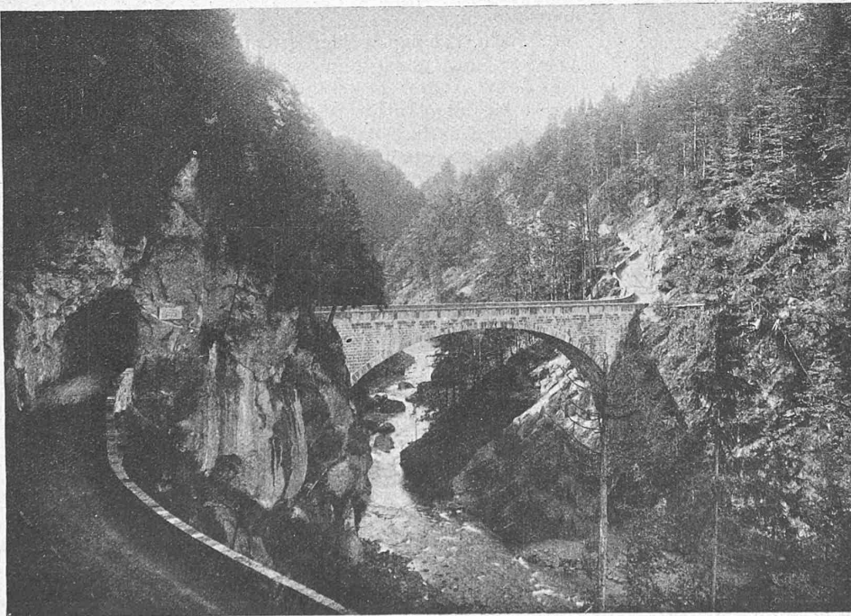
Abb. 6. Eintritt der neuen Strasse in die Lammschlucht, Blick talwärts, mit Klusstaldenbrücke.
