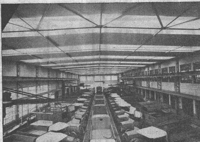
Carrosserie-Halle der A.-G. Adolf Saurer, Arbon (Innenansicht, Grundfläche 2750 m 2 .)
