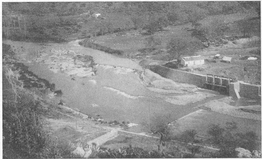
Fig. 7. Barrage et prise d'eau de l'usine de Buitreras.
