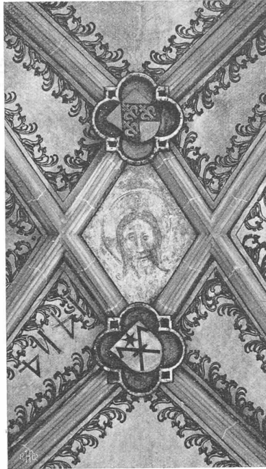
Abb. 11. Detail der Seitenschiffgewölbe.
