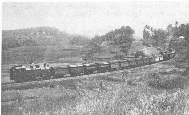
Abb. 3. Doppelzug von 300 t Anhängelast, bezw. Schiebelast.
