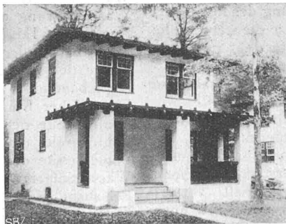
Abb. 12. Aehnliches Haus wie oben, fertig mit „Gunit“-Ueberzug.
