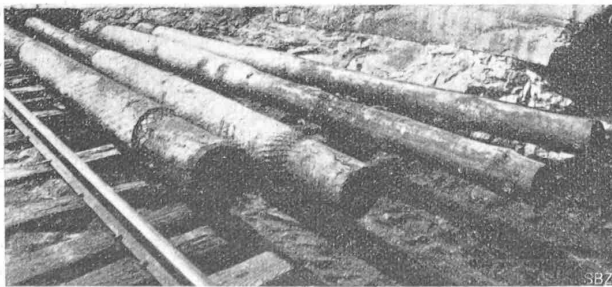
Abb. 15. Hölzerne Ramm-Pfähle mit teilweiser Schutzverkleidung aus „Gunit“, zwecks Erhärtung lagernd.
