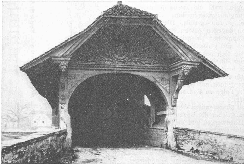
Abb. 6. Portal der Emme-Brücke bei Emmenbrücke; erbaut 1785.
