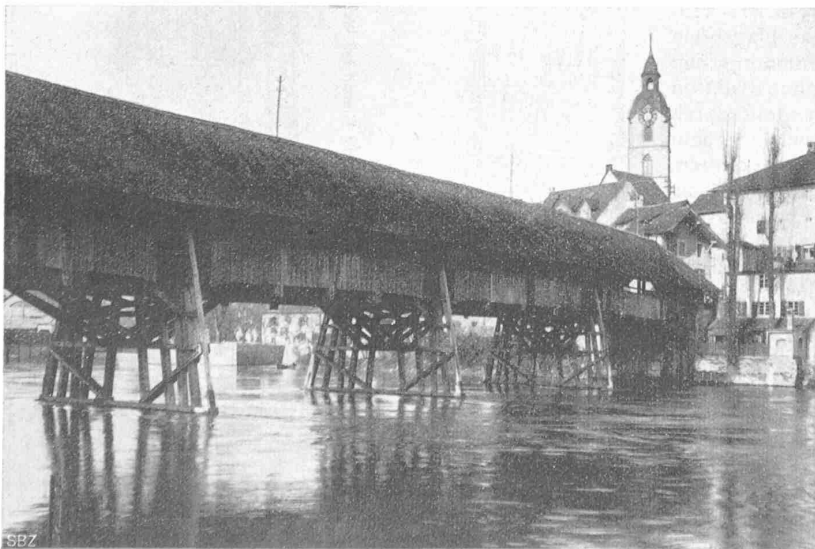
Abb. 7. Brücke über die Aare in Olten, erbaut 1803; Spannweite je 20 m.
