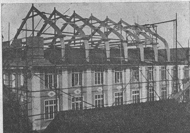
Stockwerksaufbau einer Fabrik nach Hetzer'scher Bauart.
