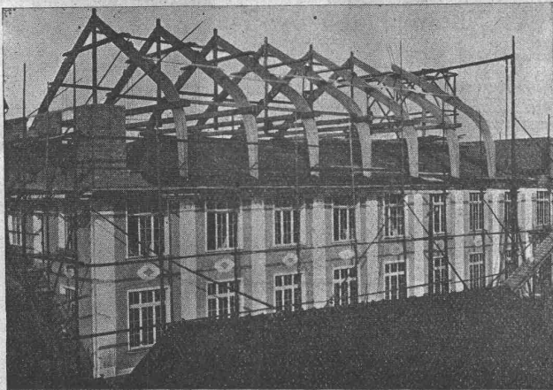
Stockwerksaufbau einer Fabrik nach Hetzer'scher Bauart.
