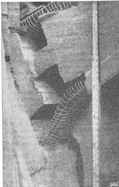
Abb. 3. Provisorisches Gelenk am Kämpfer.
