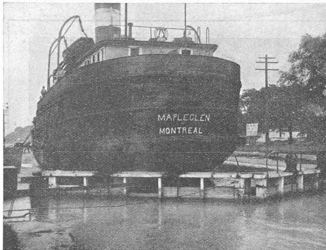
Abb. 6. Schleuse bei Thorold im kanadischen „Welland-Kanal“. Länge 85 m, Breite 14 m, Drempttiefe 4,4 m. Hölzerne Stemmtoere.
