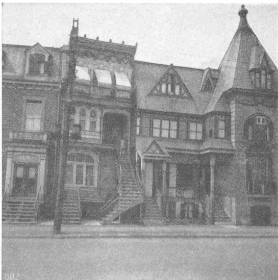
Abb. 11. Aeltere Ein- und Zweifamilien-Reihenhäuser (Montreal).
