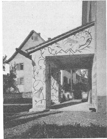
Abb. 4. Seitenansicht der Vorhalle.
