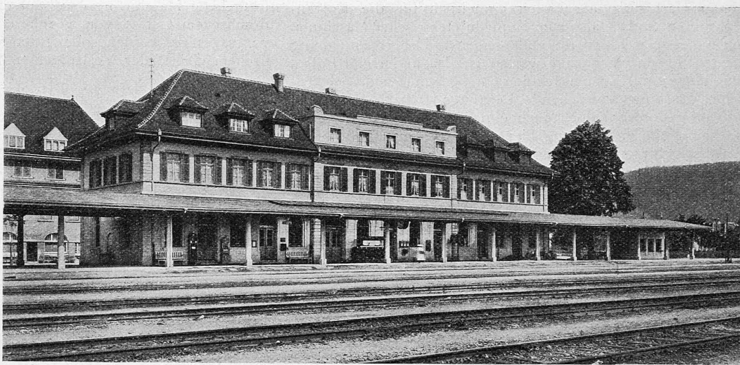
Abb. 7. Gesamtbild des durch Arch. Alb. Froelich umgebauten Bahnhofs Brugg von der Bahnseite.
