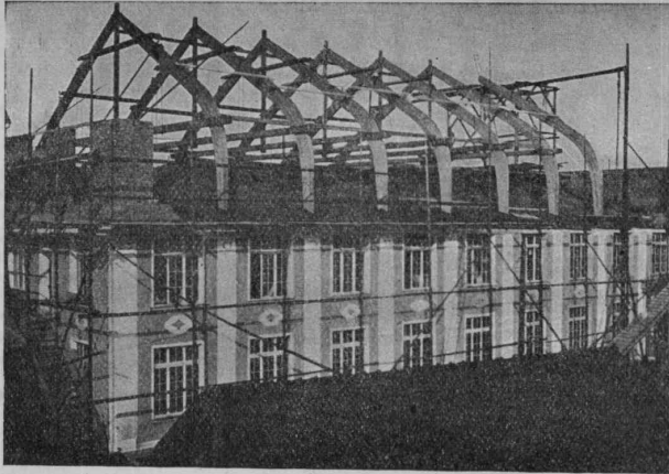
Stockwerksaufbau einer Fabrik nach Hetzer'scher Bauart.
