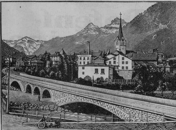
Eisenbahnbrücke ü. d. beiden Lintharme i. Schwanden
