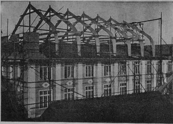
Stockwerksaufbau einer Fabrik nach Hetzer'scher Bauart.
