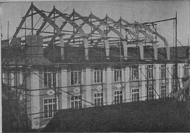
Stockwerksaufbau einer Fabrik nach Hetzer'scher Bauart.
