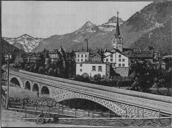
Eisenbahnbrücke ü. d. beiden Lintharme i. Schwanden
