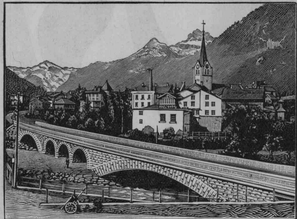
Eisenbahnbrücke ü. d. beiden Lintharme i. Schwanden
