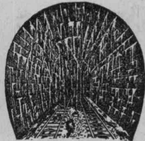
1. Vor der Dichtung nach Öffnen der Fugen
