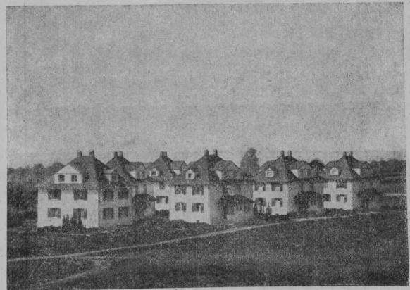
Wohnhäuser in Ziegelbrücke. Bedachungen: Eternit-Doppeldach, kupferbraun.
