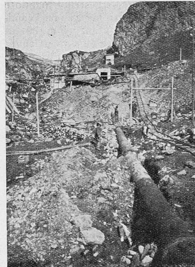
Abb. 21. Die Druckleitung Fully im Bau.
