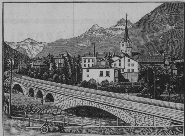
Eisenbahnbrücke ü. d. beiden Lintharme i. Schwanden
