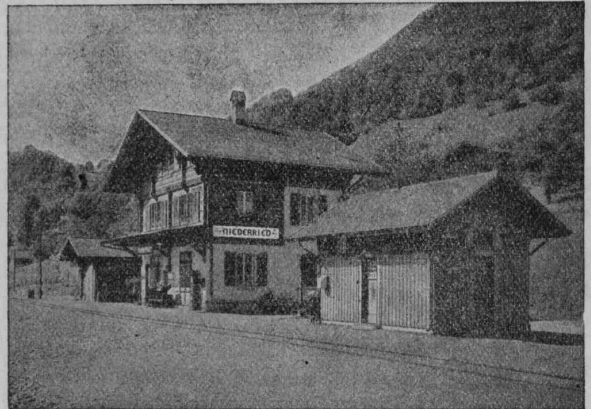
Station der Brienzseebah Eternit-Doppeldach, kupferbraun.
