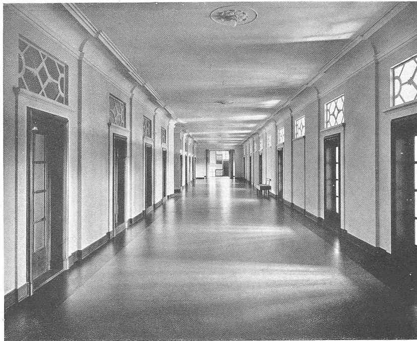
KORRIDOR EINES OBERGESCHOSSES
