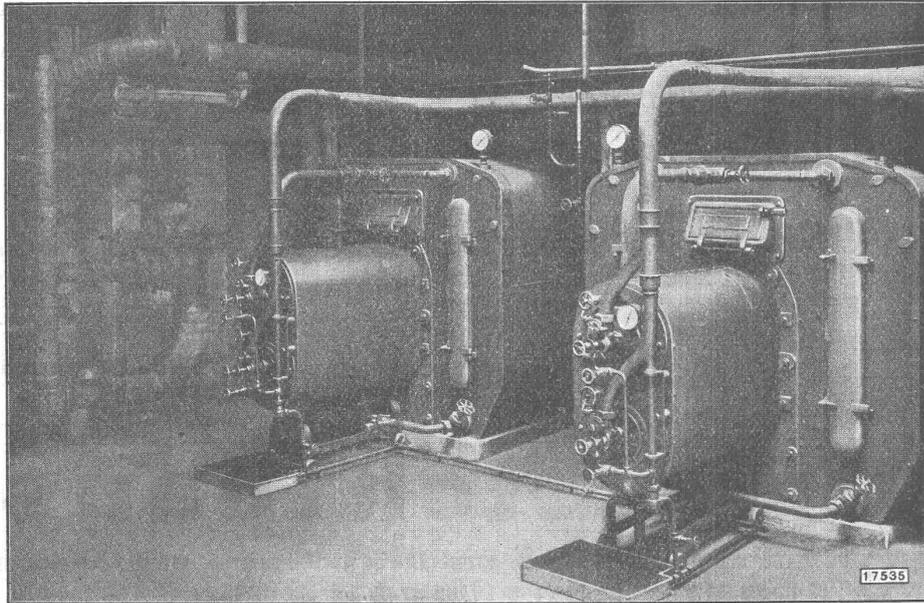
Zwei Sulzer-Oelfeuerungen an Warmwasser-Heizkesseln im Volkshaus Zürich 4
