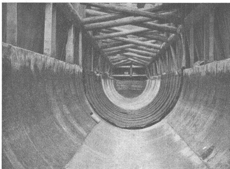
Heberleitung Kraftwerk Klosters Ausgeführt durch Locher & Cie., Zürich Abdichtung mit Mammut Ausgeführt durch Asphalt-Emulsion A.-G. Zürich
