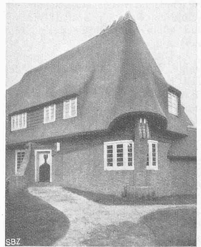
Abb. 32. Landhaus, Park Meerwijk bei Bergen. Architekt P. Kramer (1917). Organische Formung eines Baues, im Gegensatz zur geometrisch-mechanischen.
