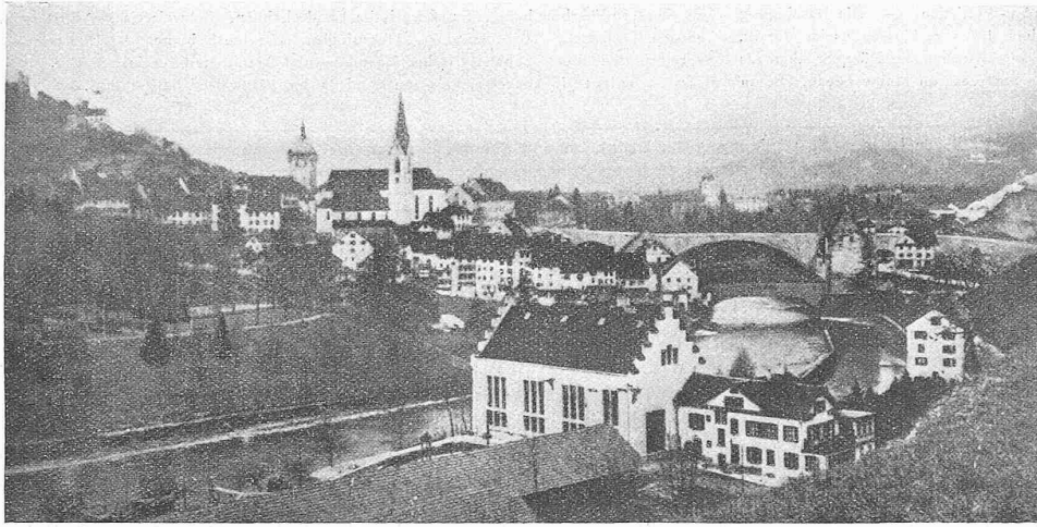
Abb. 6. Ansicht von Süden der Altstadt mit der „Stadthausbrücke“ (Experten-Projekt).
