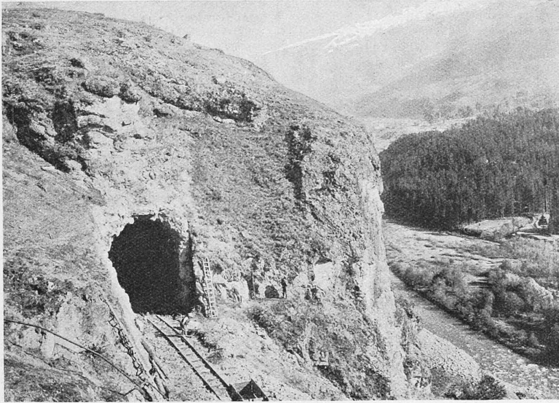
Abb. 20. Kehrabstieg der Fleimstalbahn zum Avisio (in der Tiefe rechts). Portalerweiterung des Cavalese-Tunnel in Quarzporphyr.
