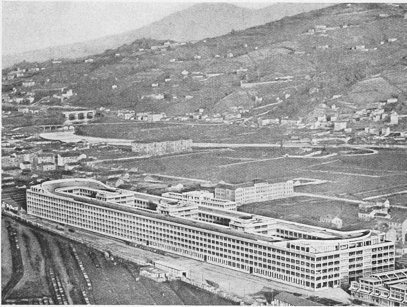
Abb. 1. Gesamtansicht der neuen Automobilfabrik Fiat im Lingotto bei Turin.
