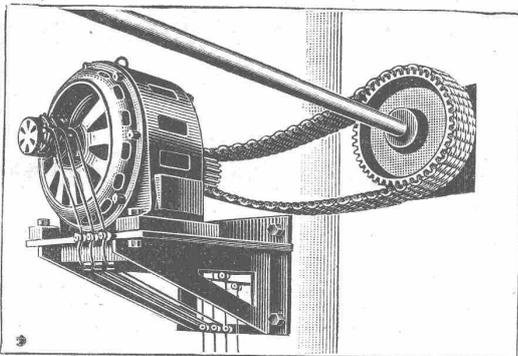
Positive Kraftübertragung bei kleinsten Wellenabständen, daher Platzersparnis.
