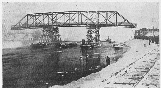
Verlegung der Mainbrücke Viereth unterhalb Bamberg.
