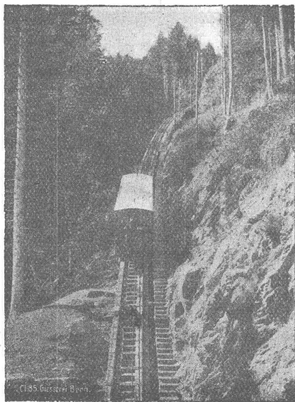
Seilbahn Niesen, I. Sektion, maximale Steigung 66 ‰.
